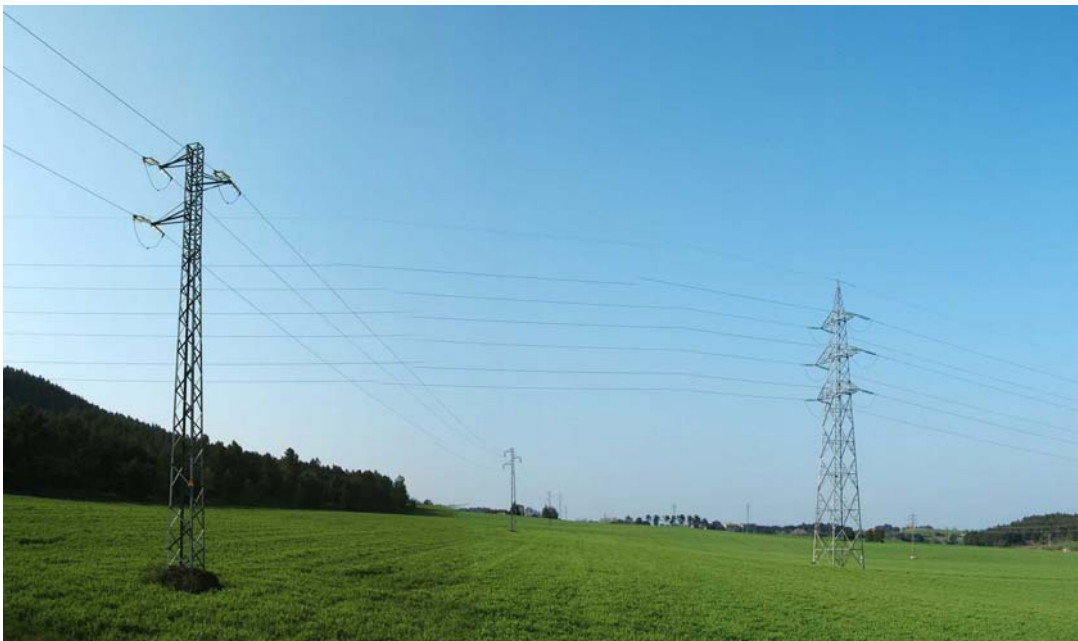
Fotografia 6. Línies elèctriques al sector de la República (Palol de Revardit)
