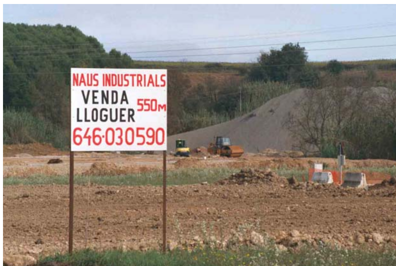
Fotografia 7. Sòl industrial en construcció al terme municipal de Porqueres.
